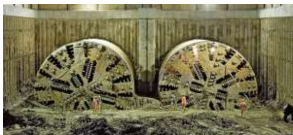
Metroul din Doha realizat de Aktor cu utilaje Herrenknecht
