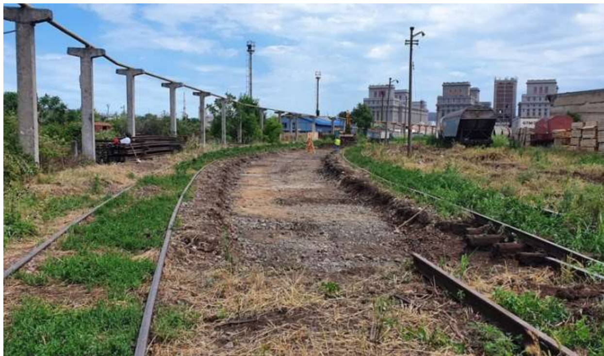
Foto: CFR Infrastructura
