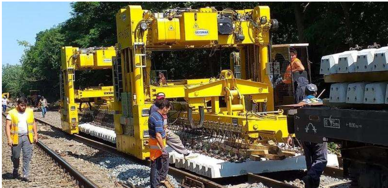
Lucrari feroviare Foto: CFR Infrastructura
