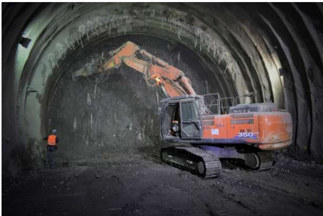
Sursa Foto : Asociația Pro Infrastructură
