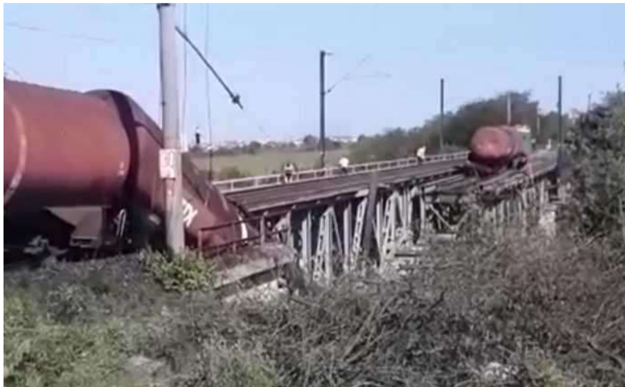
Reconstrucția viaductului Cârcea.
