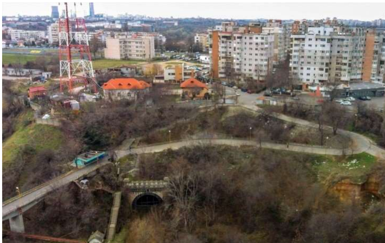
Tunelul feroviar Palas - Port
