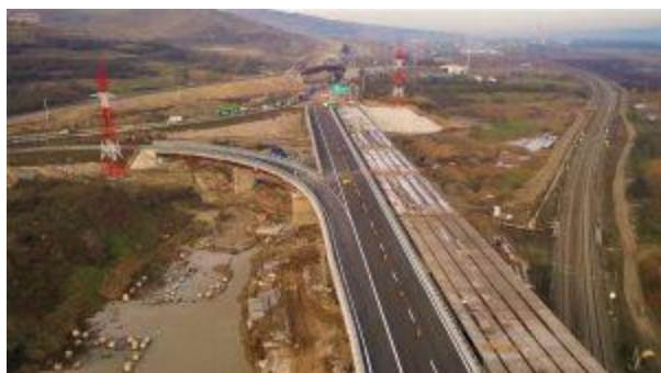
FOTO Asociația Pro Infrastructură
