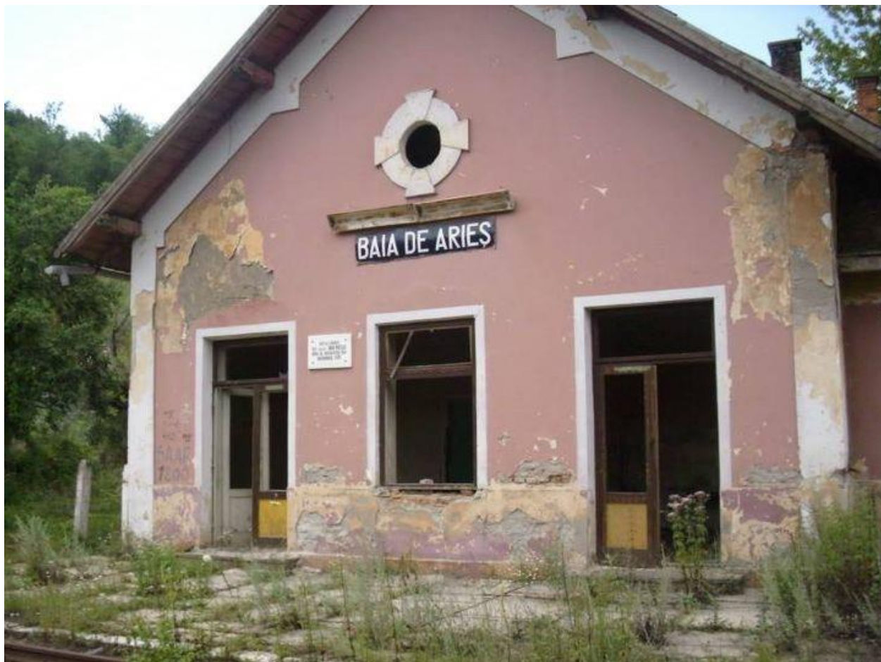
Cladirea fostei gari din orasul Baia de Aries
