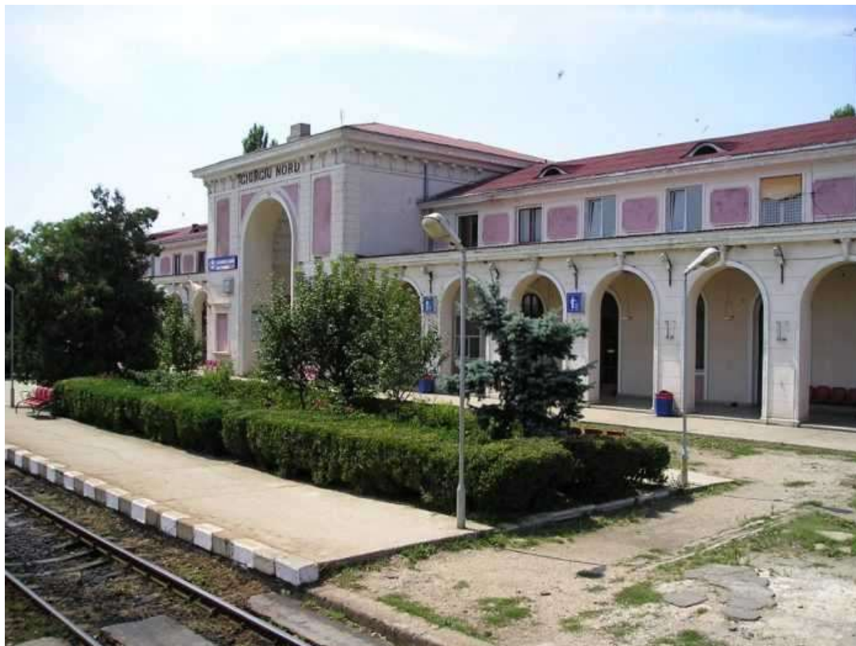
Stația de frontieră Giurgiu Nord
