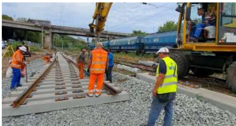
Lucrări la linia ferată din portul Constanța FOTO: CFR Infrastructură
